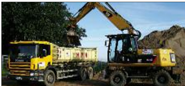
Bei HMH steht für Abriss, Entsorgung und Schüttgutbelieferung das passende Gerät zur Verfügung.
