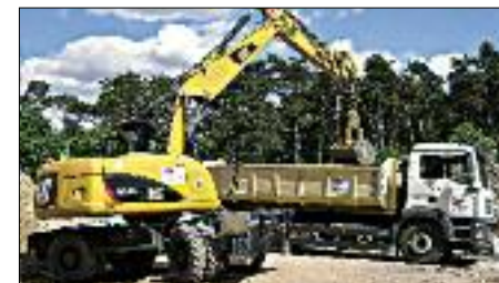
Schwerpunkte von HMH sind die Containerbereitstellung sowie Erd- und Schachtarbeiten.
