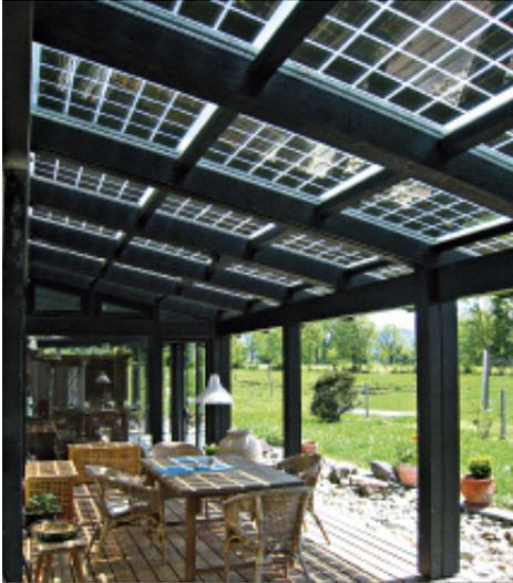
■ Innovative Solarmodule eignen sich als stromerzeugender Wetterschutz und transparentes Dachsystem.
