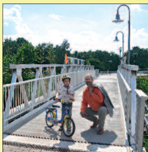
■ Die Zühlsdorfer Brücke gehört zu den wichtigen Bauwerken.
