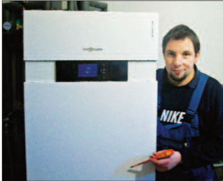
■ Christian Neumann kennt sich besonders gut mit der sparsamen Wärmepumpen-Technik aus.
