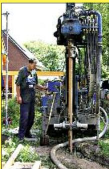
Mit Erdwärme wird man dauerhaft von Gas- und Ölpreisen unabhängig. Der Fachbetrieb von **Antje Spintig** und **Michael Spintig** führt die dafür nötigen Bohrungen in bis zu 100 Metern Tiefe durch.
