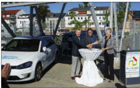
■ Die neue Solartankstelle bietet Gratisstrom für Elektrofahrzeuge.
