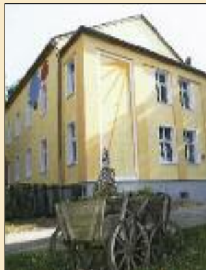
Die Stadt Erkner hat die Fassade der Kita „Kinderhaus Sonnenschein“ wunderbar saniert.
