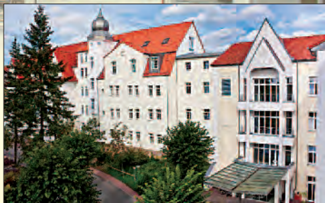
■ Die Sanierung des über 100 Jahre alten Haus 1 verbessert die Behandlungsmöglichkeiten für die zumeist älteren Patienten.
