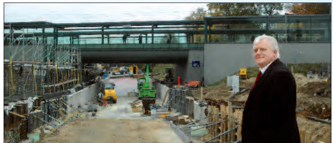
■ Ende in Sicht? Laut Bahn soll die Unterführung zum Jahresende 2011 endlich fertig werden.
