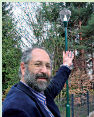
■ Mit LED-Leuchtkörpern in den Straßenlampen lässt sich 90 Prozent Energie einsparen.
