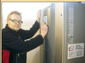
Luft-Wasser-Wärmepumpen eignen sich für Beheizung und Warmwasserbereitung für Ein- und Mehrfamilienhäuser. „Ihr
