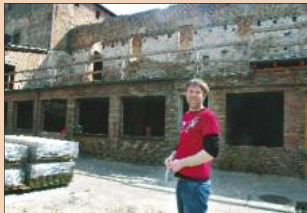
Wo heute tote Fensterlöcher zu sehen sind, sollen Künstlerwohnungen und Ateliers zum offenen Austausch führen.
