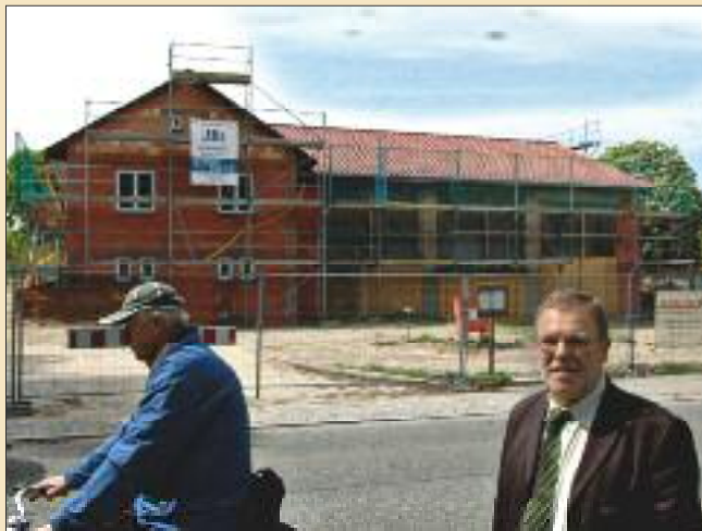
In Glindow bekommt die Feuerwehr den lang-ersehten Neubau.
