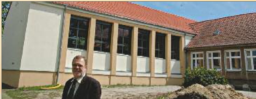
Die Turnhalle in Glindow wurde nun wie neu.
