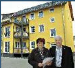
Das Haus Phöbener Straße 105 wurde komplett entkernt und bietet jetzt attraktive Wohnungen.
