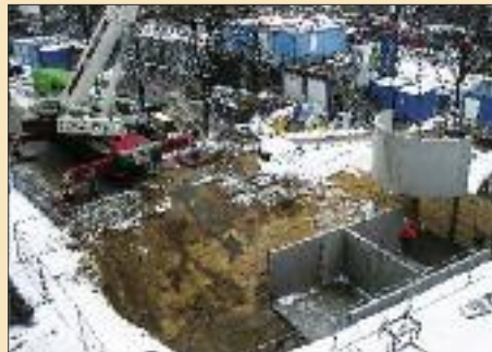
Das Team von Guido Bauch errichtete die Zisterne im Berliner Königstadt-Caréé.
