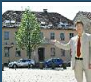
Das Haus Am Markt 3 mit dem barocken Balkon und neuer Fassade zieht viele Blicke auf sich.
