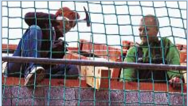
Den letzten Nagel schlagen die Bauherren selbst ein.
