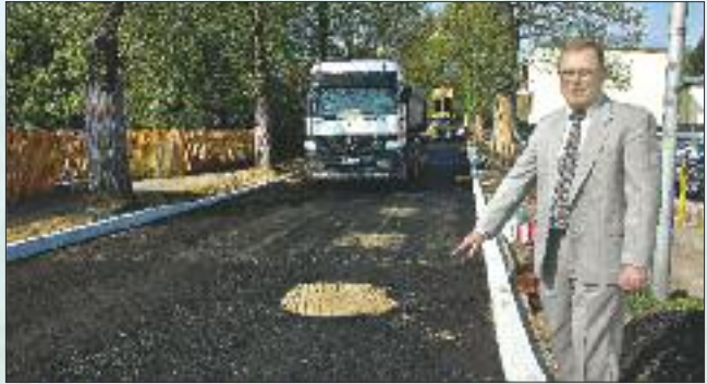
Wo die Stadt zuständig ist, wie hier am Kesselgrund, wird zügig gebaut.
