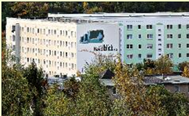
■ In den Häusern der Wohnungsgenossenschaft Havelblick lässt es sich gut und günstig wohnen.
