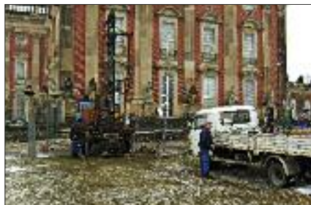
■ Der Fachbetrieb aus Phöben hat für das Schloss-theater im Neuen Palais den Löschwasserbrunnen gebohrt.
